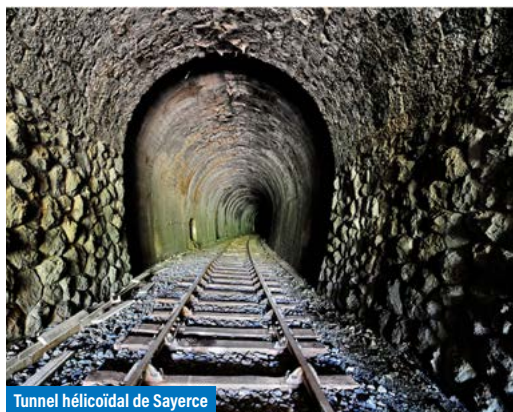
Tunnel hélicoïdal de Saperce
