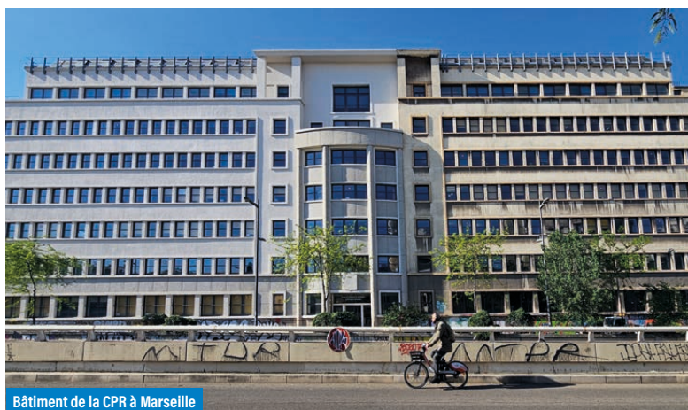
Bâtiment de la CPR à Marseille
