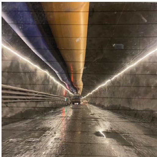
et le stockage des matériaux d'excavation, la stabilisation par bétonnage de la voûte nouvellement créée et... nouveau cycle de 24 heures.
