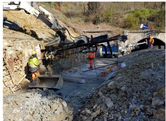
C'est l'Entreprise sous-traitante (NGE) qui a mobilisé des appareils exceptionnels pour réaliser ces travaux dans cette zone difficile. Une grue ferroviaire a permis de lever jusqu'à 100 tonnes et d'acheminer les engins et les matériaux nécessaires au confortement.
